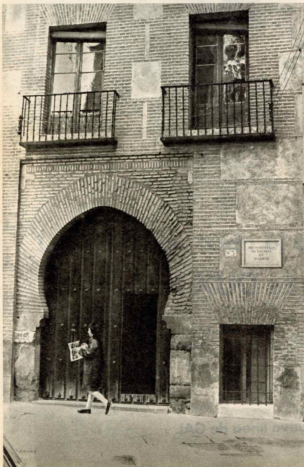
Fachada de la Hemeroteca Municipal.
